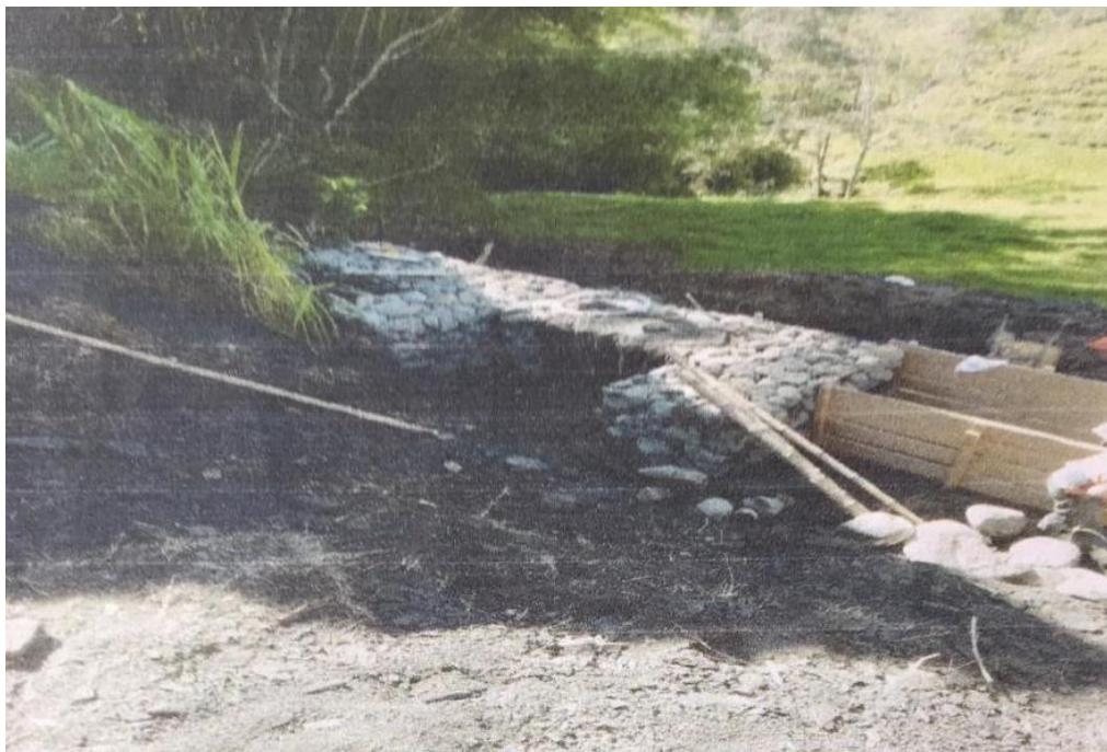
Registro fotográfico de muro de gavión construido en el barrio San Martin.
