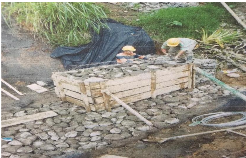
Registro fotográfico de muro de gavión construido en el barrio San Martin.
