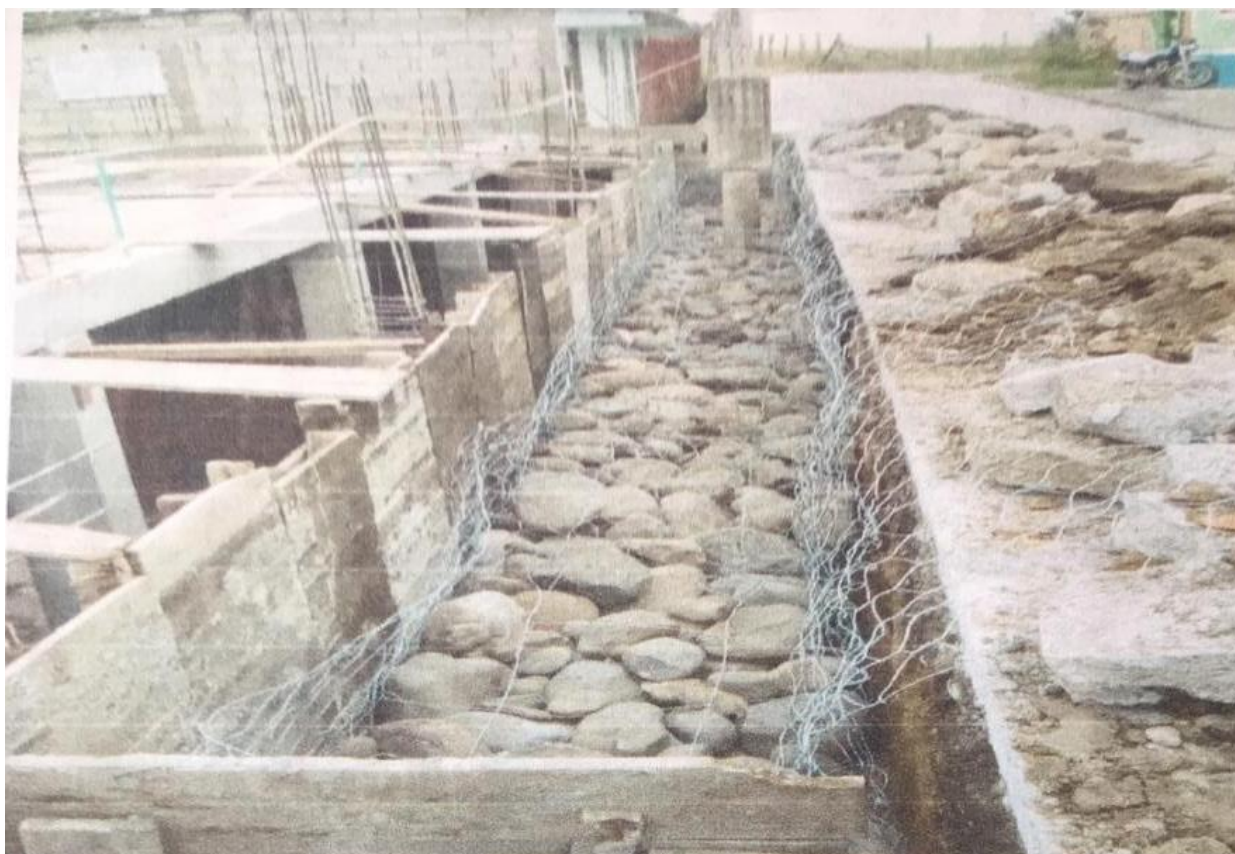
Registro fotográfico de proceso constructivo de muro de gavión en el barrio El Progreso, Cra 1ra entre calles 5 y 6.
